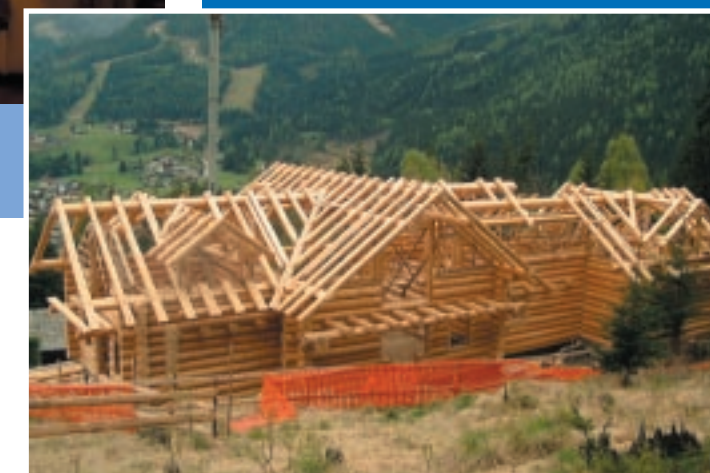
Imposanter Rohbau auf 1.150 m
